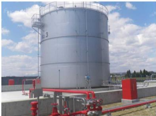
Рисунок 8. Эксплуатация топливных резервуаров на базе Касумимэ
