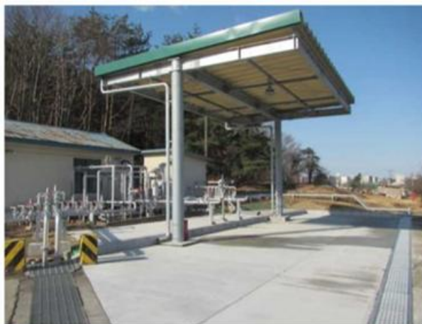
Рисунок 12. Построенный заправочный пункт на базе Тагадзё
