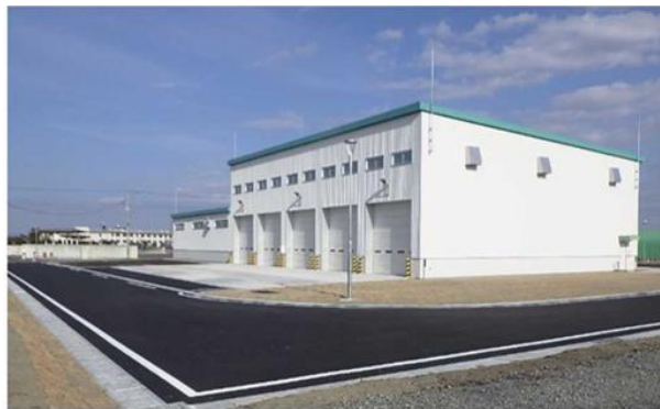
Рисунок 6. Построенный склад учебного оборудования на военной базе Корияма
