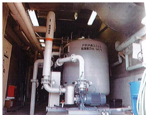
Рисунок 7. Модернизация системы циркуляции и фильтрации на военной базе Фукусима
