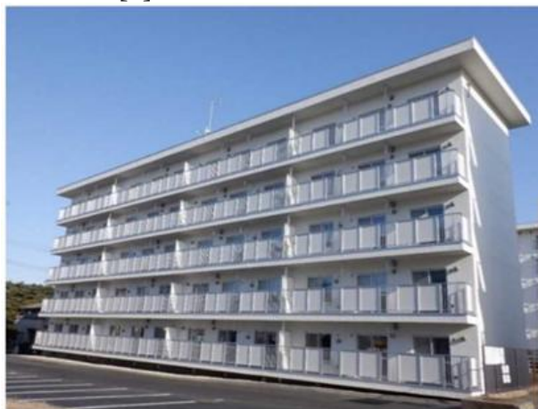
Рисунок 4. Реконструкция служебного жилья на военной базе Тагадзё
