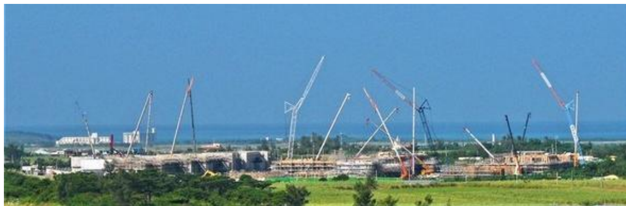
Рисунок 10. Строительство ракетной базы Сил самообороны на острове Миякодзима, префектура Окинава
