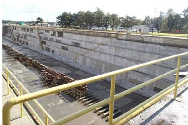
Рисунок 9. Ремонт дока в городе Муцу, префектура Аомори
