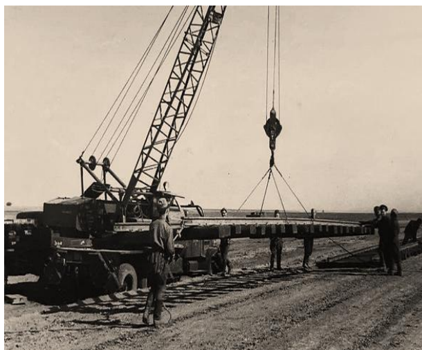
Фото 25. Укладка рельсошпальной решетки на обходе Мариновка – Донская личным составом батальона майора Ж.Г. Иссаакяна
