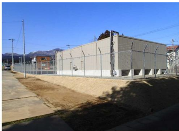
Рисунок 11. Ремонт резервуара для приема воды на военной базе Фукусима
