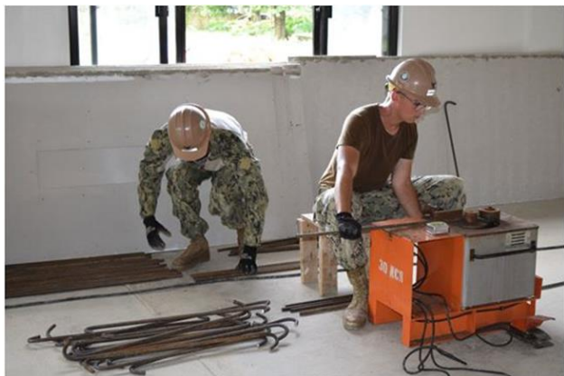
Рис. № 9 – строительство казармы личным составом 1-го морского мобильного строительного батальона на острове Басилан, Республика Филиппины, 2002 год
