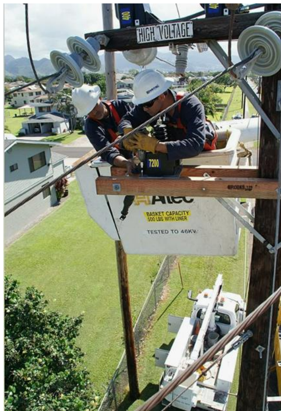
Рис. № 6 – монтажные работы на электросетях объектов ВМС на Гавайях
