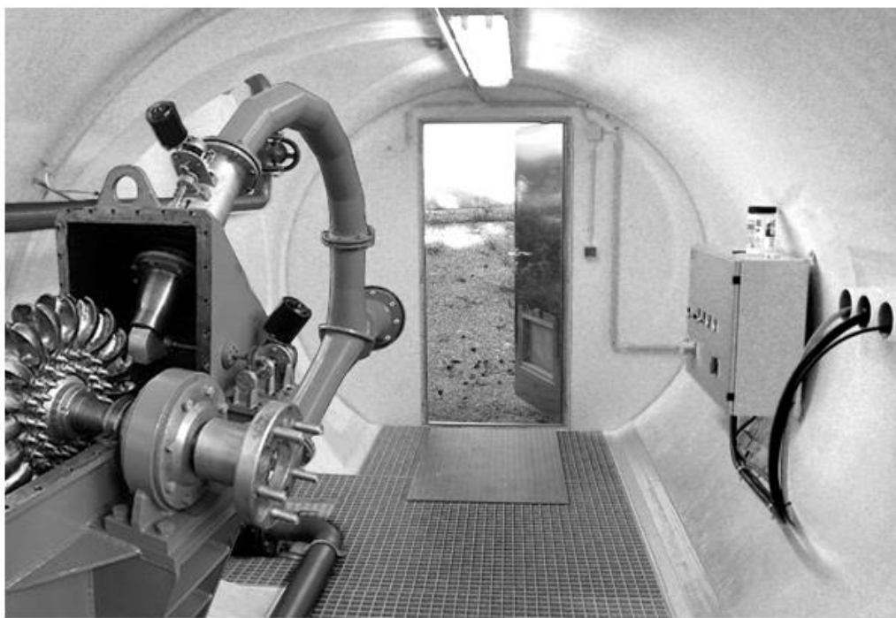
Рис. 7. Размещение гидрогенерирующей установки (мини ГЭС) в «сухом» отделении хозяйственно-питьевого резервуара
